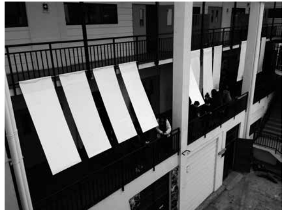
Trabajo de montaje, zona CIDP.
